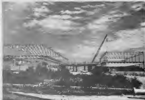
NEARLY COMPLETED, the building's bones sparkle in the Caribbean sun. CERCA CLA, wesonan di e edificio ta brilla den solo di Caribe.
